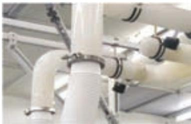
La tubería ProVent™ está específicamente diseñada y fabricada para sistemas de ventilación y extracción de vapores corrosivos. Supera en desempeño a los sistemas de PVC, fibra de vidrio y metal laminado debido a su resistencia
